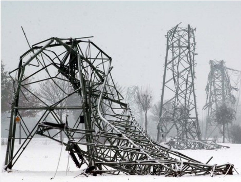
Electrical tower in eastern Thuringia dpa_kreiszeitung.de 09.12.2010
