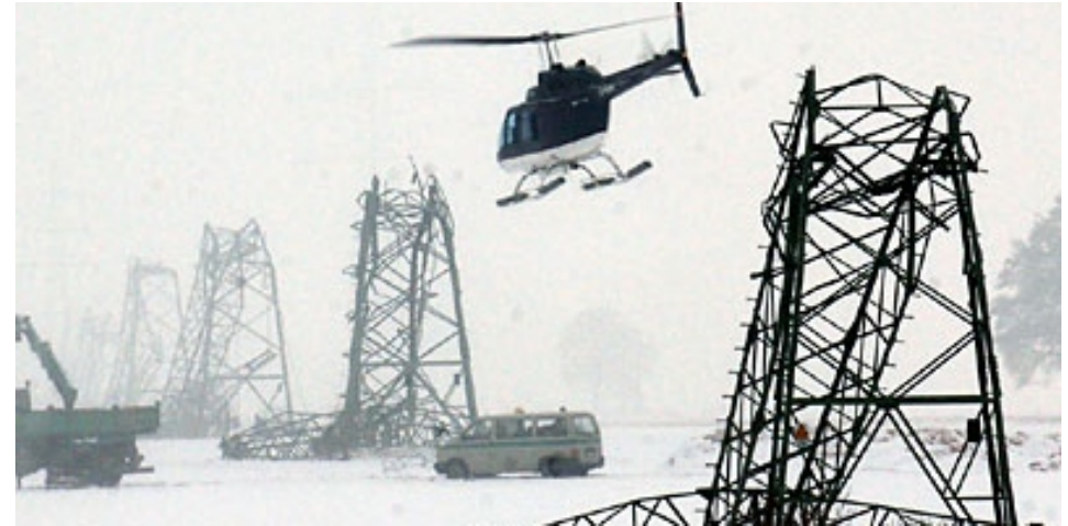
Electrical tower close to Münster Sueddeutsche.de 04.12.2005
